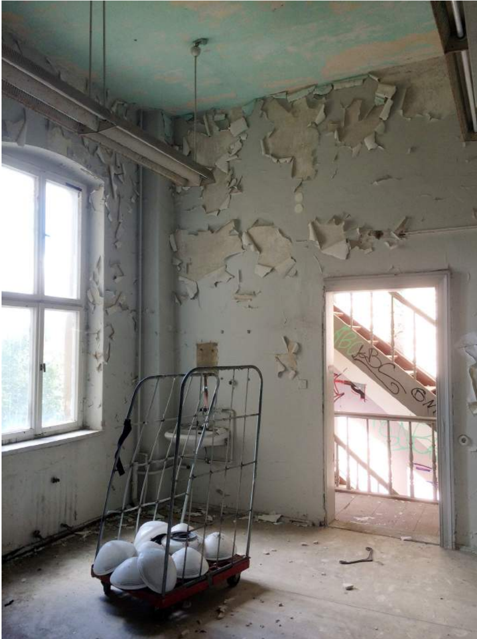
Hinterraum im zweiten Obergeschoss mit Blick auf das rückseitige Treppenhaus zum Hof
